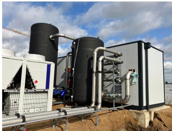
Abbildung 3: Außenansicht der Technikzentrale mit Blick auf die Speicher
