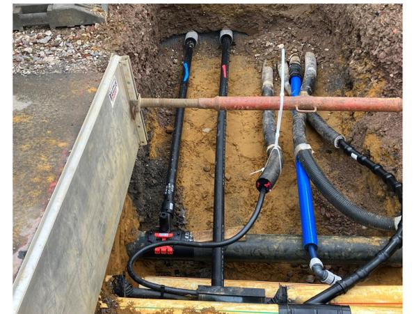
Abbildung 4: Verlegung der ungedämmten Rohrleitungen
